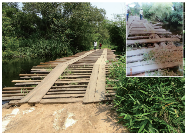
ボロンボ川の橋の修理前(右上)と修理後
